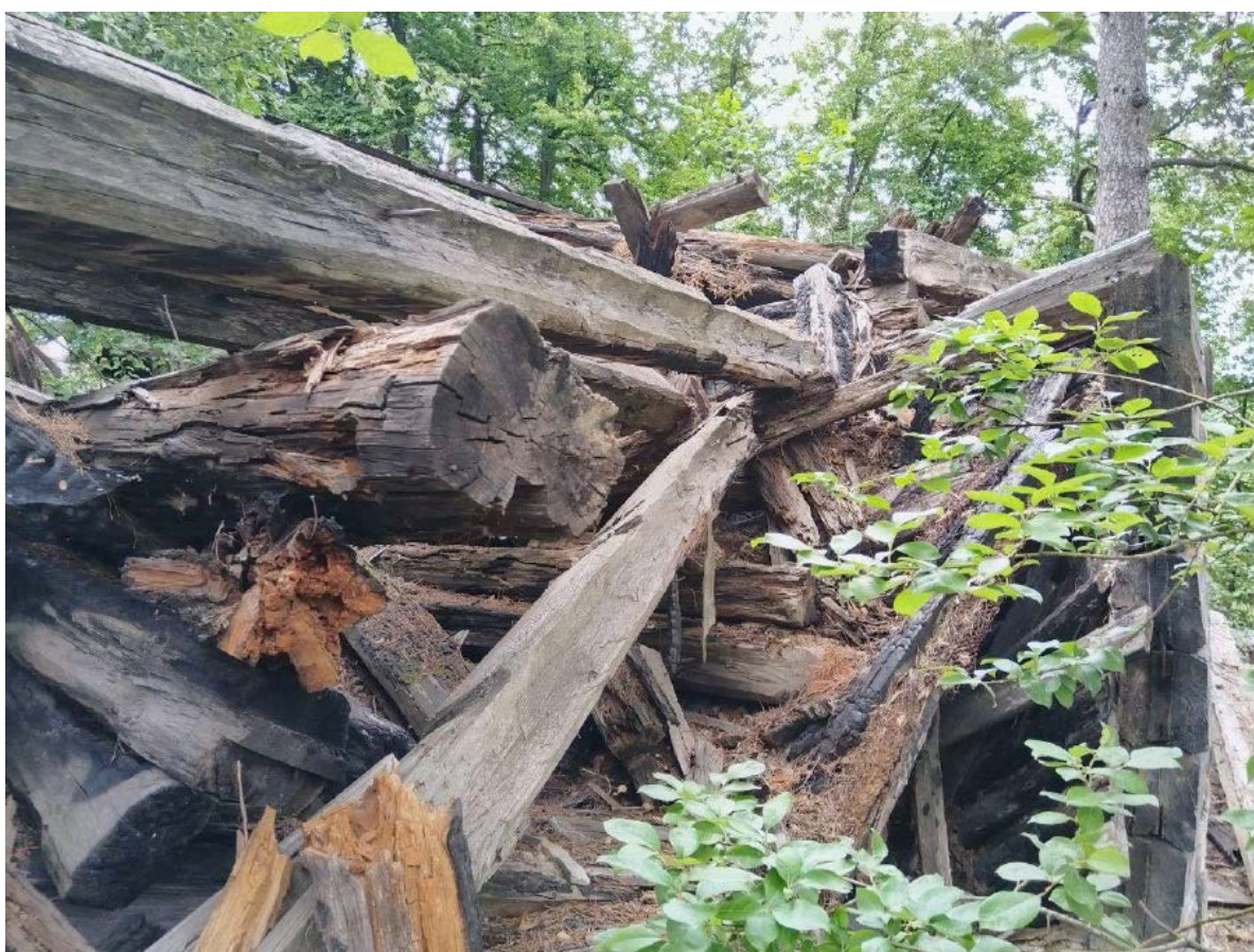
Т.ф. 32. Конструкции внутри здания
