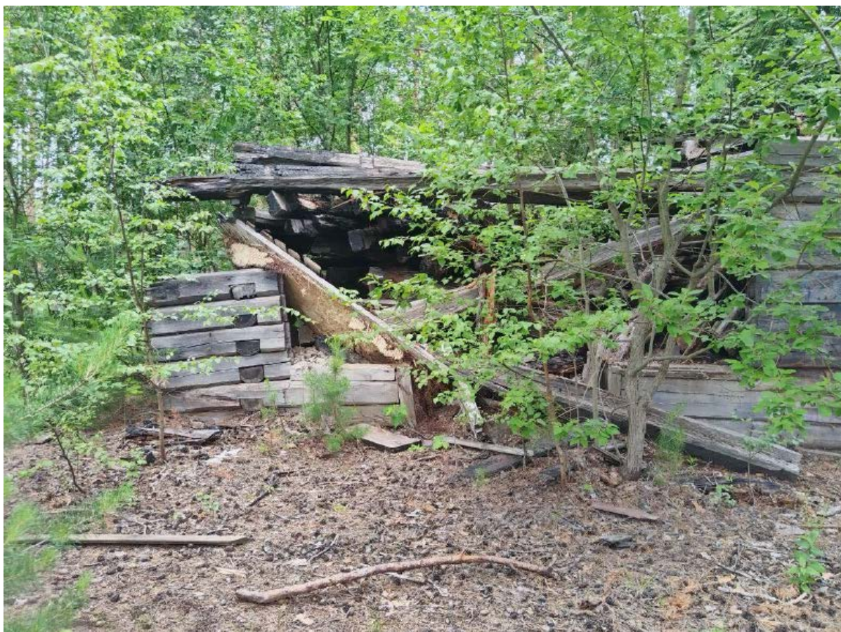
Т.ф. 12. Фрагмент фасада здания с южной стороны. Вход в здание
