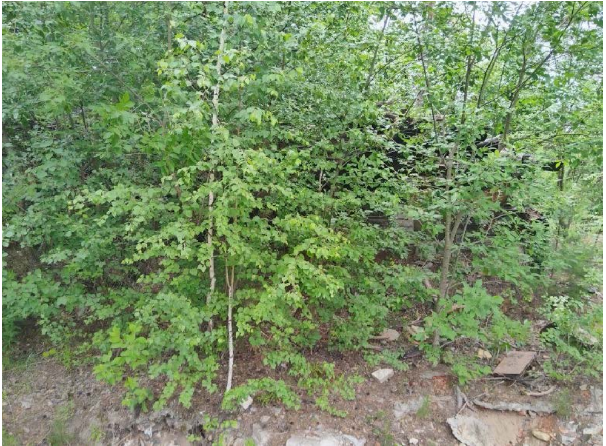
Т.ф. 25. Фрагмент здания с западной стороны (скрыт в зарослях)
