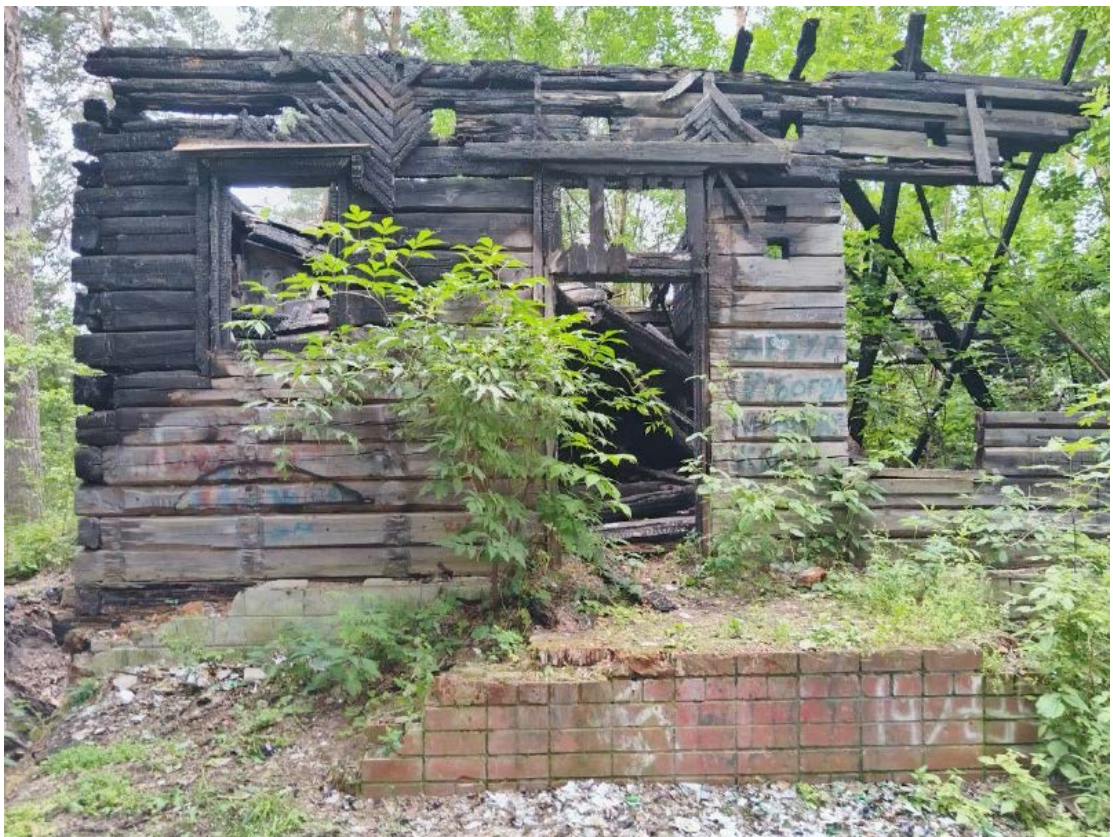
Т.ф. 2. Фрагмент здания с северной стороны
