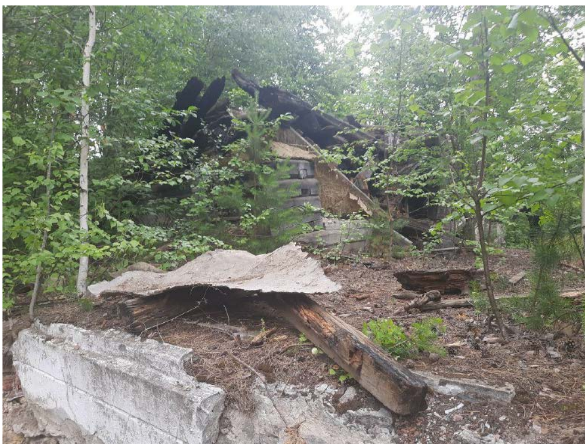
Т.ф. 24. Фрагмент фасада здания с юго-западной стороны (скрыт в зарослях)
