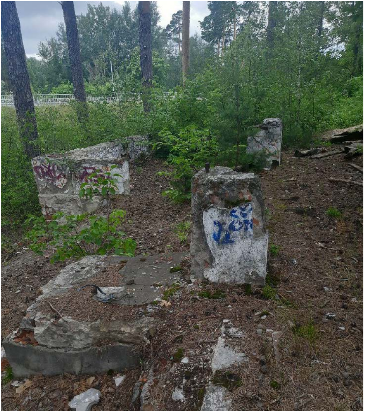
Т.ф. 18. Фрагмент террасы с восточной стороны. Элементы ограждения
