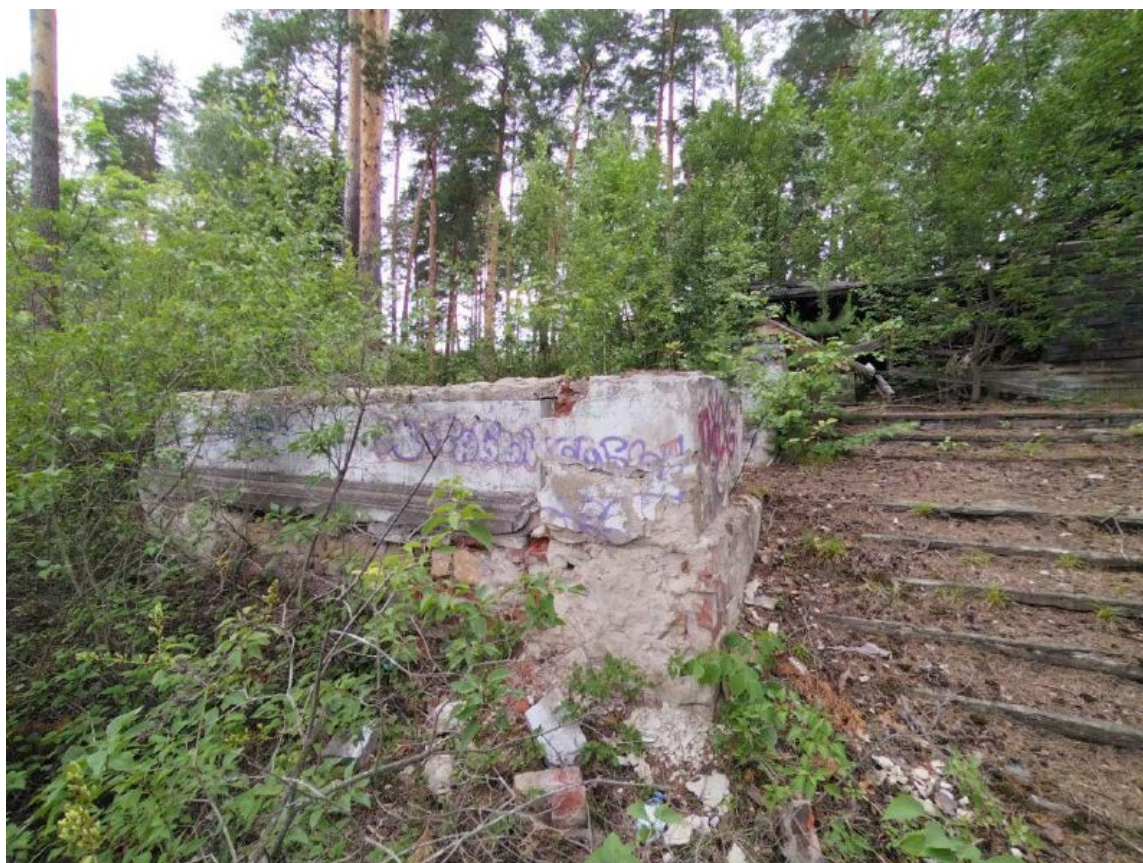
Т.ф. 15. Фрагмент террасы с южной стороны
