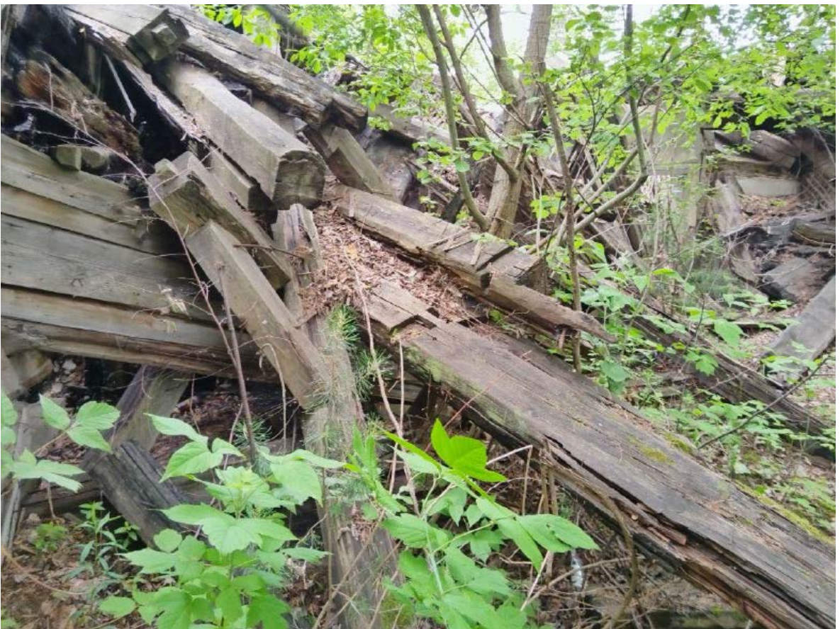
Т.ф. 26. Фрагмент здания с западной стороны (скрыт в зарослях)
