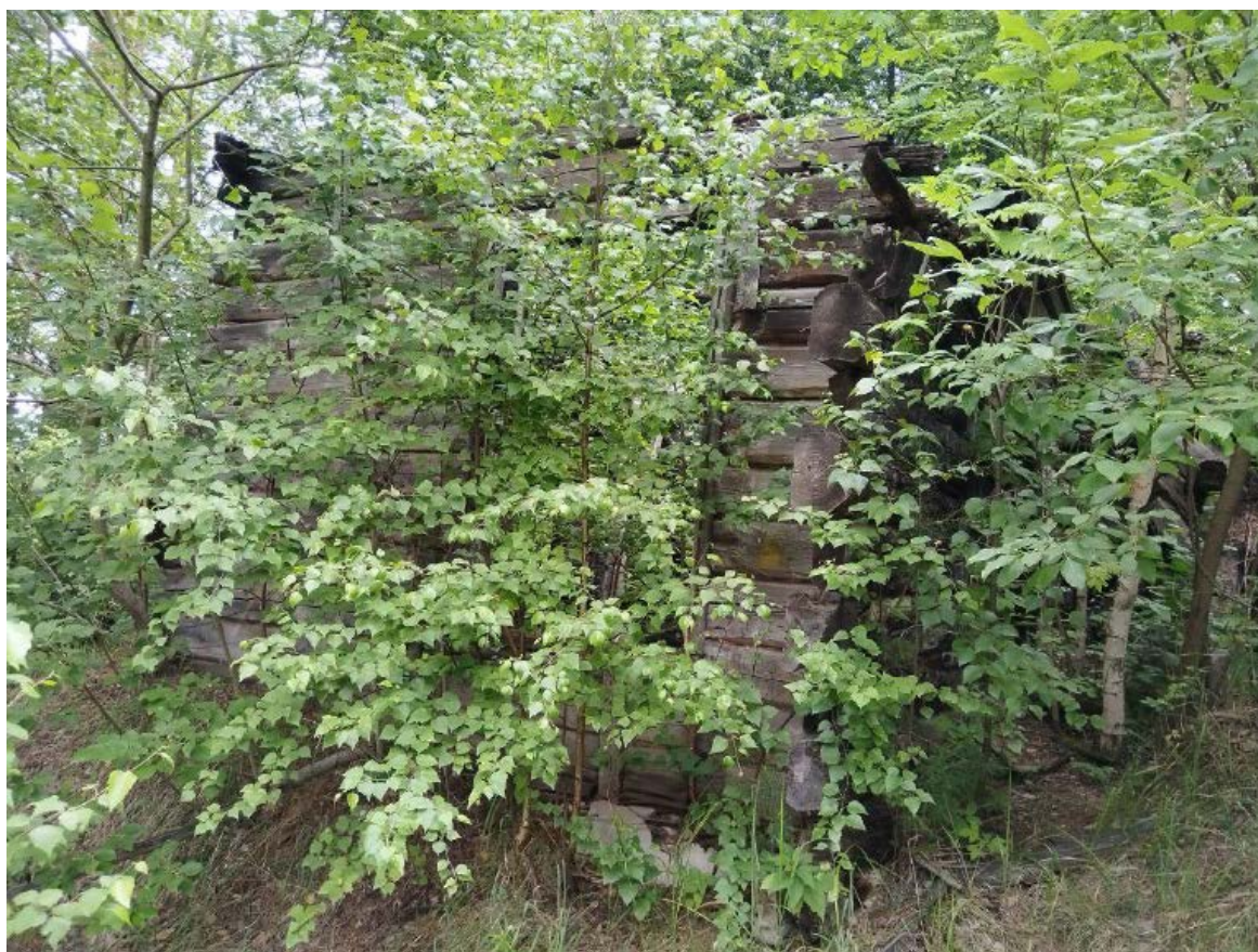
Т.ф. 28. Фрагмент здания с западной стороны (скрыт в зарослях)
