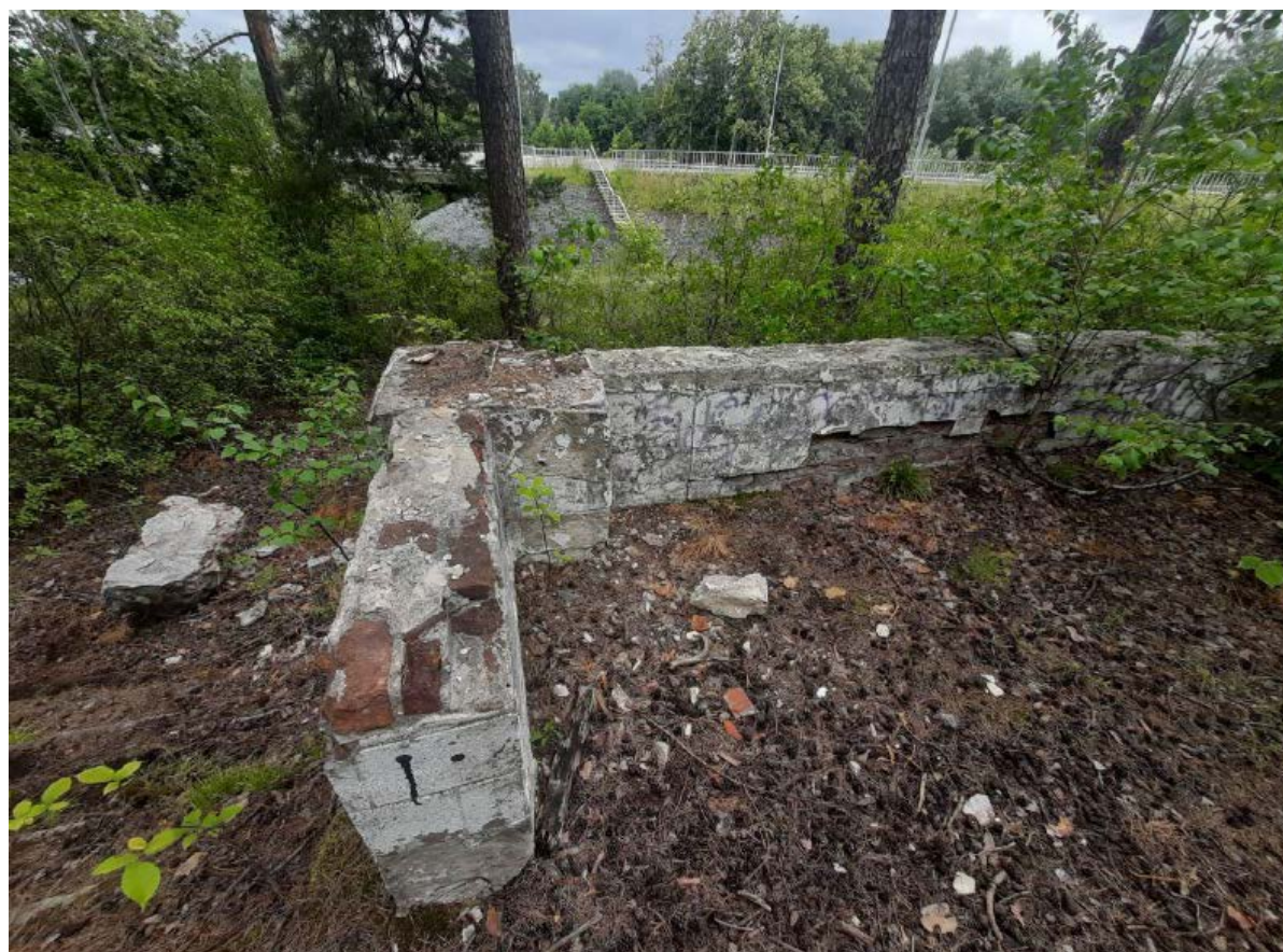
Т.ф. 20. Фрагмент террасы с северной стороны. Подпорная стена
