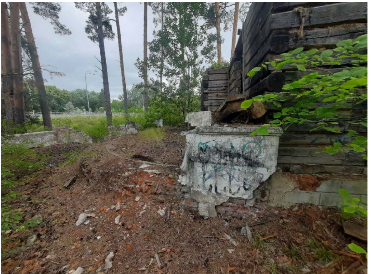
Т.ф. 17. Фрагмент террасы с восточной стороны
