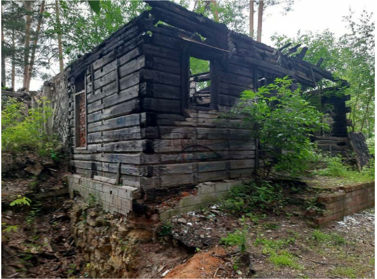
Т.ф. 3. Общий вид здания с северо-восточной стороны
