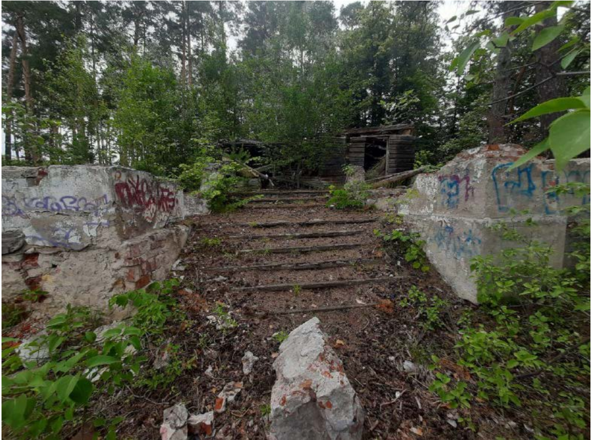
Т.ф. 10. Общий вид фасада здания с южной стороны. Фрагмент террасы
