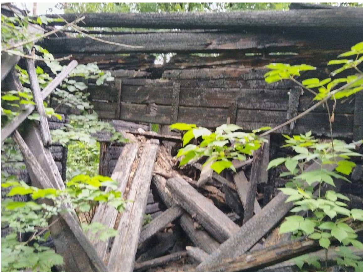
Т.ф. 31. Конструкции внутри здания
