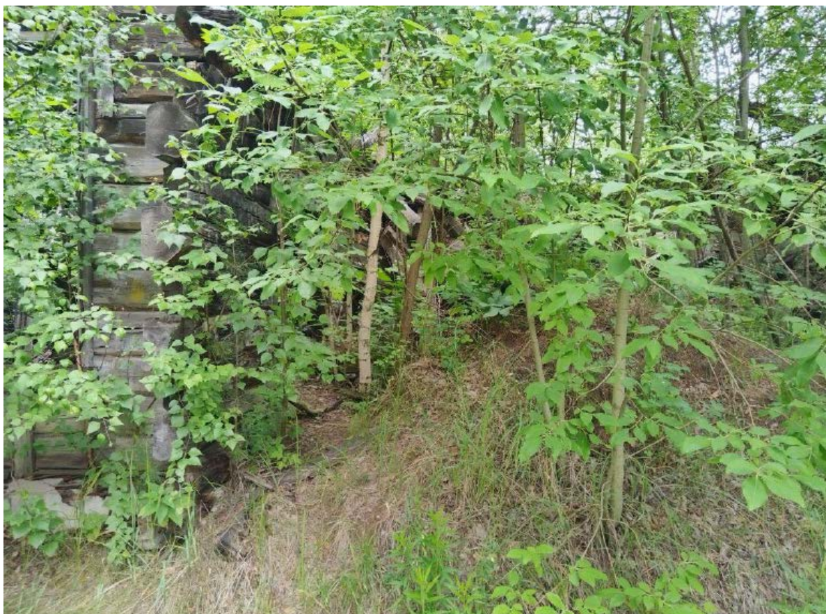
Т.ф. 27. Фрагмент здания с западной стороны (скрыт в зарослях)
