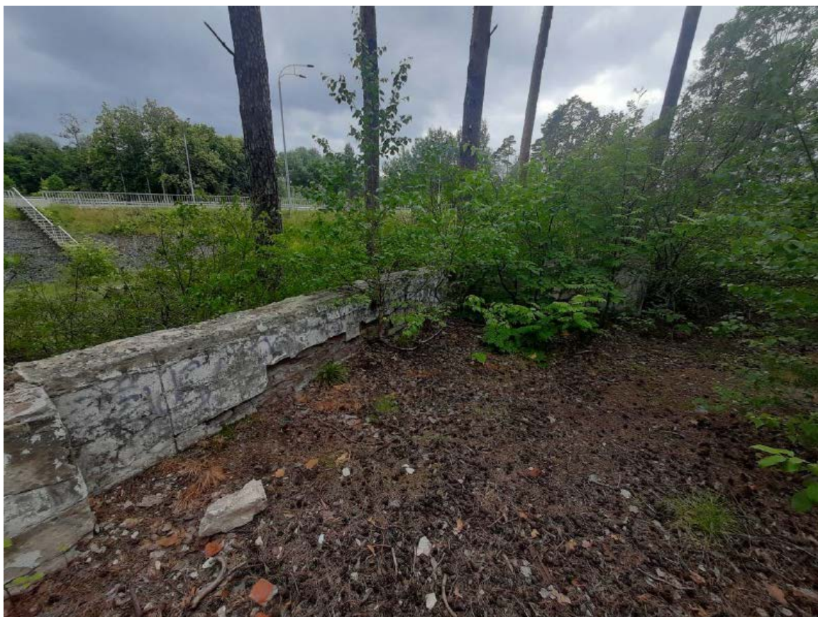
Т.ф. 21. Фрагмент террасы с северной стороны. Подпорная стена
