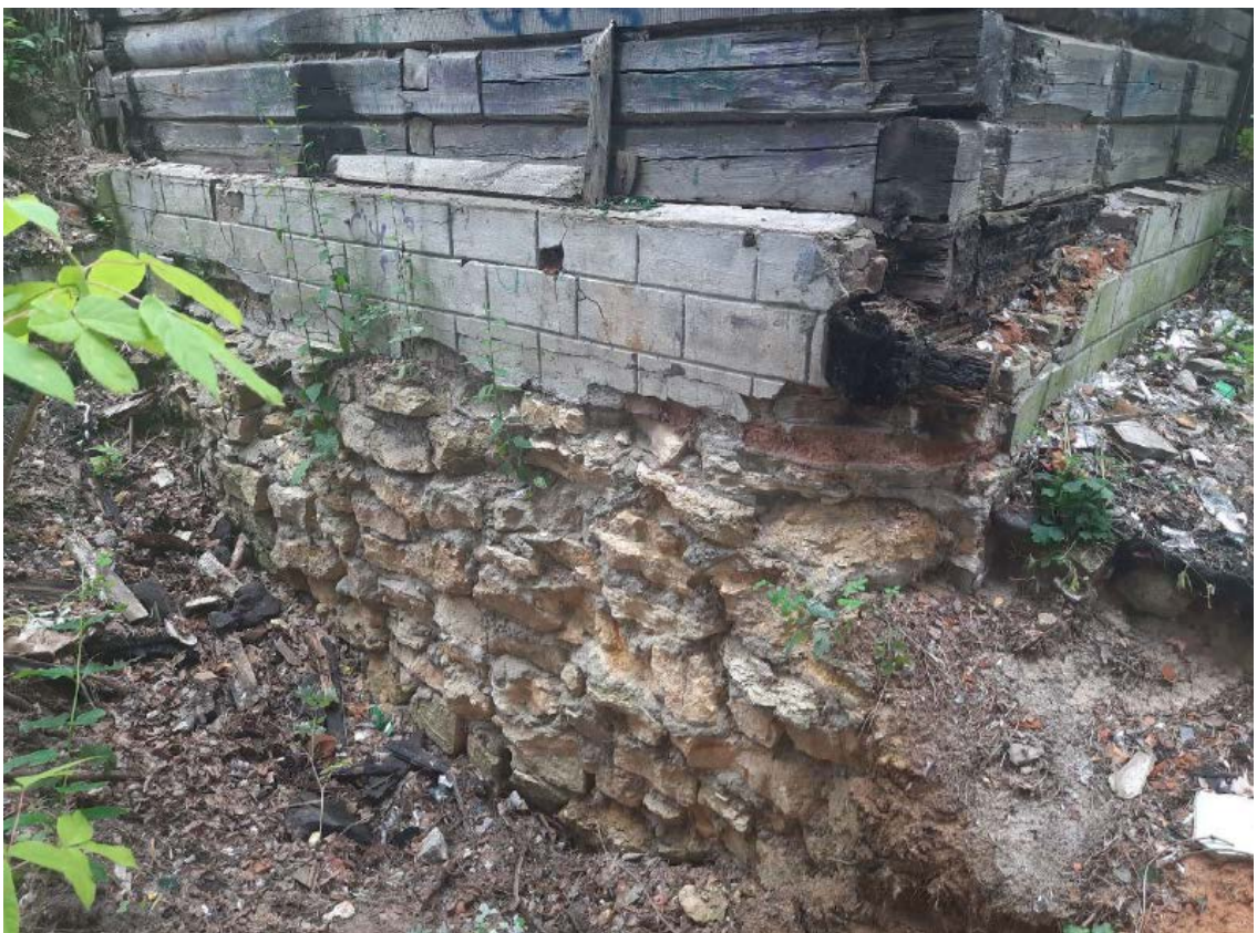
Т.ф. 4. Фрагмент здания с северо-восточной стороны. Существующий шурф. Цоколь и фундаменты здания
